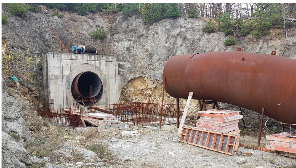
Fig. 19 CHE Bumbesti power structure
