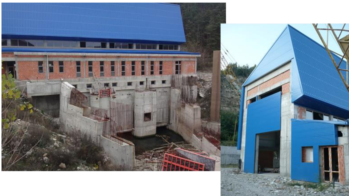
Fig. 24 CHE Bumbesti – exterior
